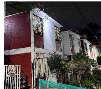
Figura 1.- Casas duplex de un solo nivel comunes en México.
